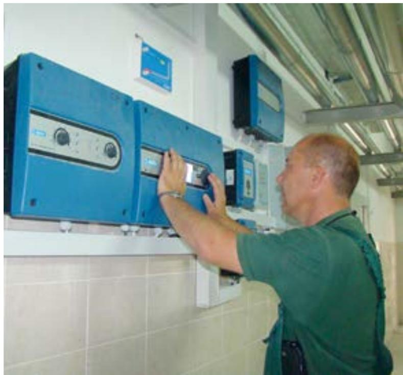
**Щит распределительный системы жидкого кормления с встроенным компьютером**
