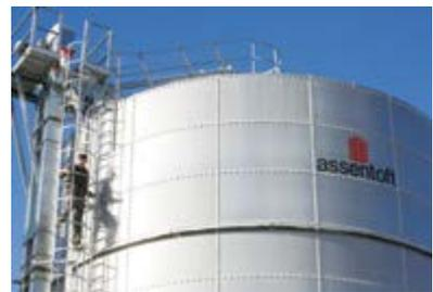
Бункеры разработаны для условий эксплуатации с учетом высокой снеговой и ветровой нагрузки.
