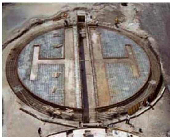
В случае установки силосов на фундамент используется система вентиляции с каналами в виде буквы «Н» или двойной «Н». Состоит из гладких и перфорированных настилов, балок шириной в 100 мм, поддерживающих стоек высотой в 305 мм, перфорированных лент, рифленых накладок, уголков и зажимов. Гладкие и перфорированные настилы сделаны из оцинкованной стали толщиной в 1,17 мм или 1,83 мм
