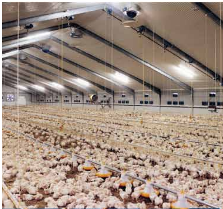
Вентиляционная система полного цикла для птицеферм
