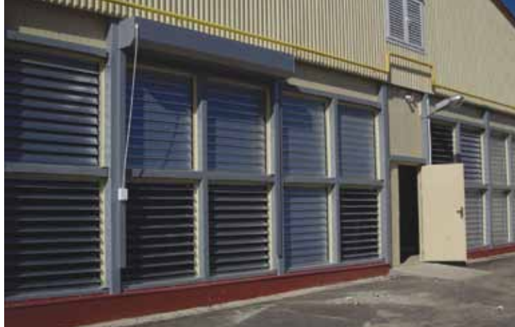
Тоннельный эффект при скорости движения воздуха около 2 м/с работает гораздо эффективнее для охлаждения птицы, чем большинство известных систем охлаждения
