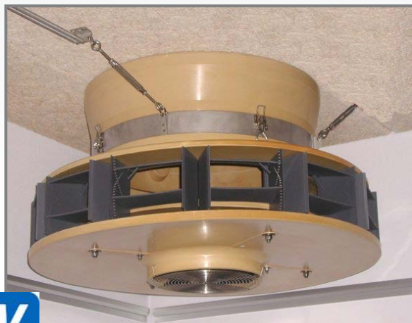
Приточная шахта DA 40
